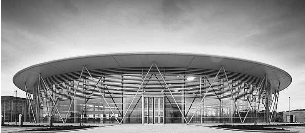
写真3 ファクトリー 2050の全景（出所）AMRCウェブサイト
