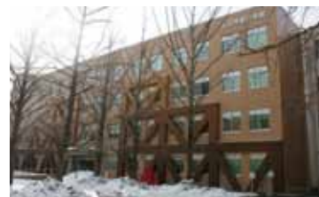
明るい外壁になった2号館
