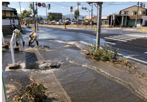
写真2 氾濫によって水没した歩道 (松波地区交差点, 2019.10.13山田撮影)
